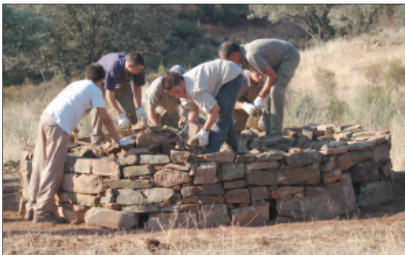
Figura 7.17. Proceso constructivo de un majano de tipo Montiel. Se pueden apreciar las entradas situadas a 1 m de distancia. El diámetro empleado, de 5 m, hace que el majano posea una superficie cercana a 20 m 2 .
